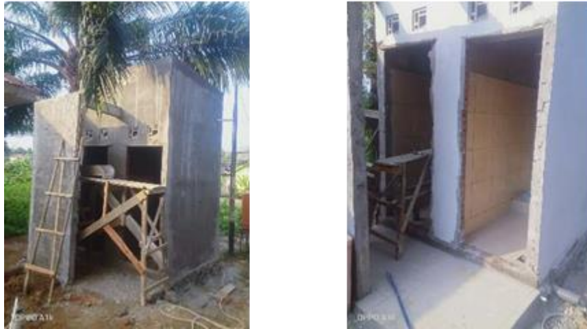
Gambar 6. Proses pekerjaan pembangunan 60%
