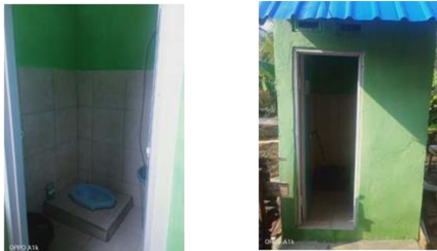
Gambar 7. Proses pekerjaan pembangunan 100%
