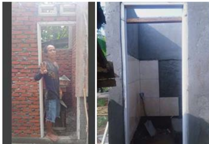
Gambar 5. Proses awal pekerjaan pembangunan
